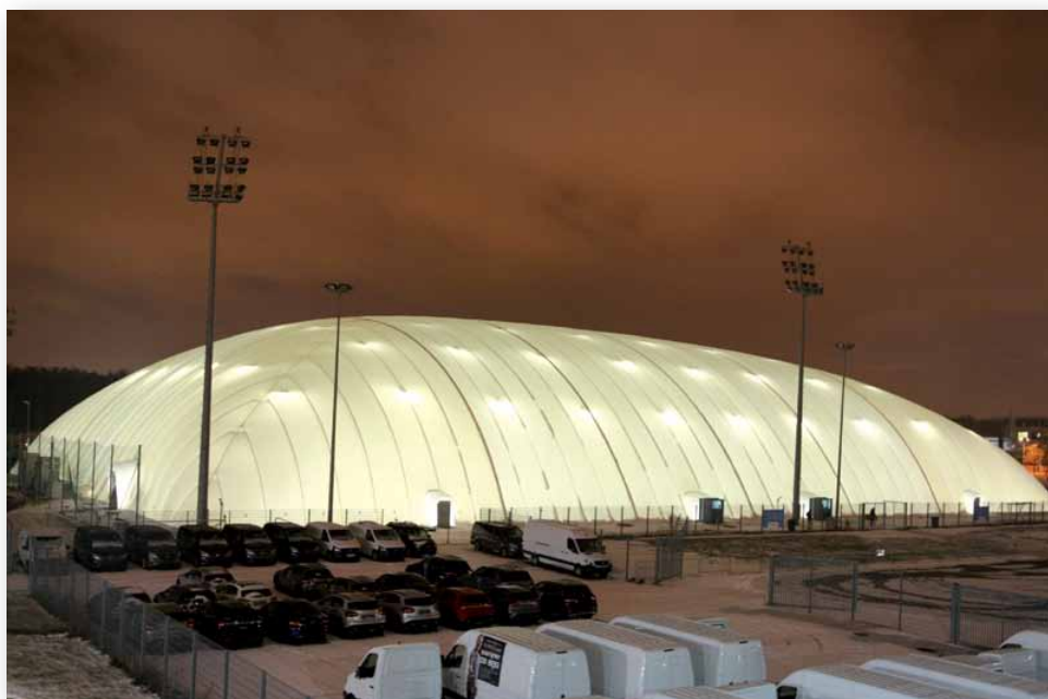
Hala w technologii podwójnej membrany nad pełnowymiarowym boiskiem treningowym Lecha Poznań
