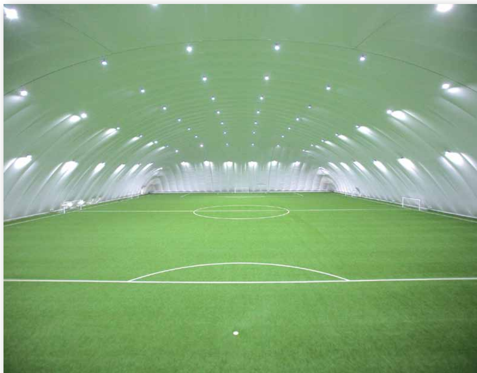
Hala z podwójną membraną nad pełnowymiarowym boiskiem przy ul. Meissnera w Gdańsku
